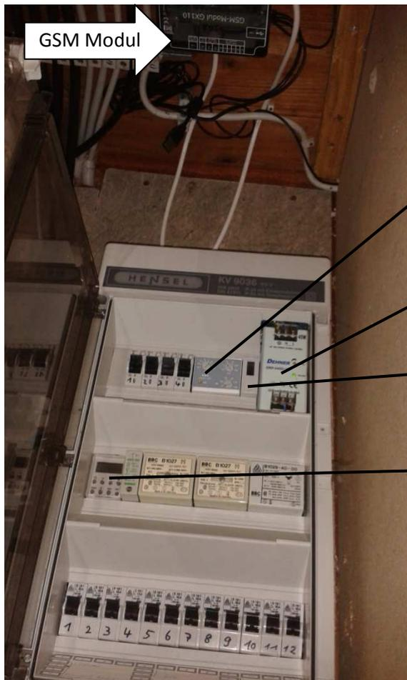
Elektrokasten in der Herrenumkleide mit GSM Fernschaltmodul für die Beheizung der Wasserspeicher und des Nachtspeicherofens im Sanitärgebäude:
